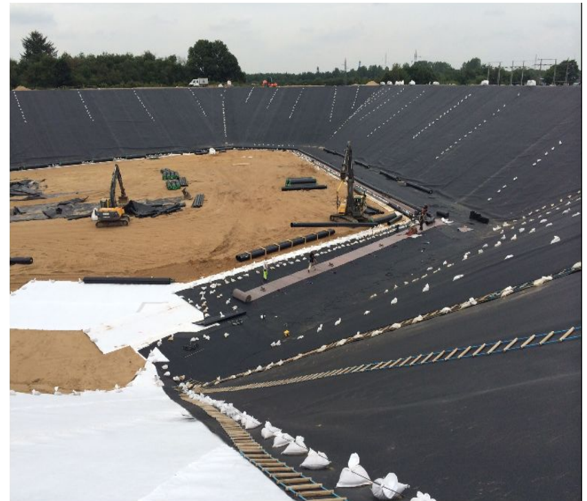
Foto: Damvarmelager, Planenergi
